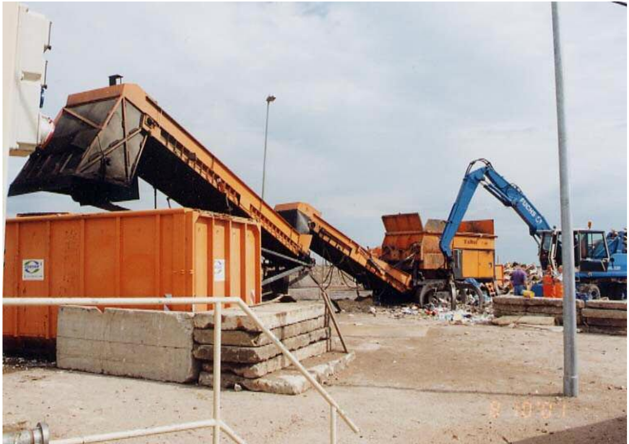
Abbildung 3 Mechanische Aufbereitung MBA Deponie Cottbus- Saspow
